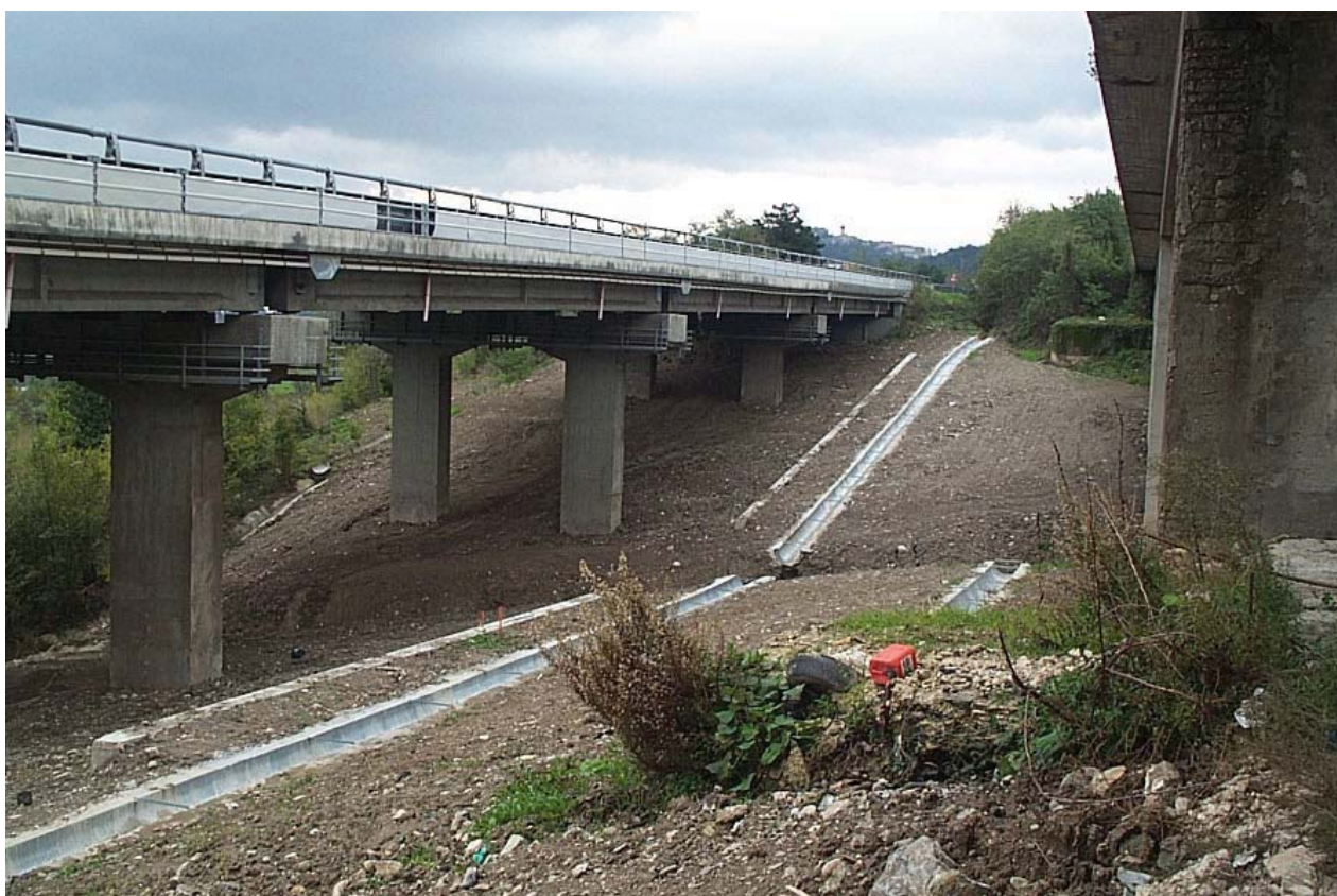
Foto 25: area sotto un viadotto che è stato oggetto di lavori di rinforzo delle fondazioni e di consolidamento frana di versante
