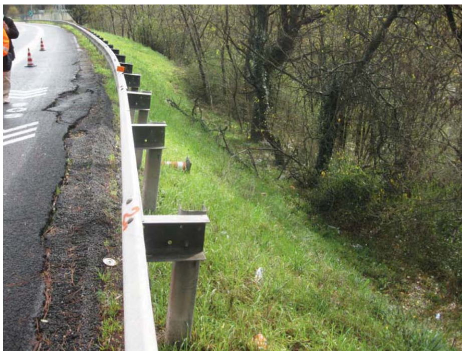
Foto 3: es. d'instabilità banchine
