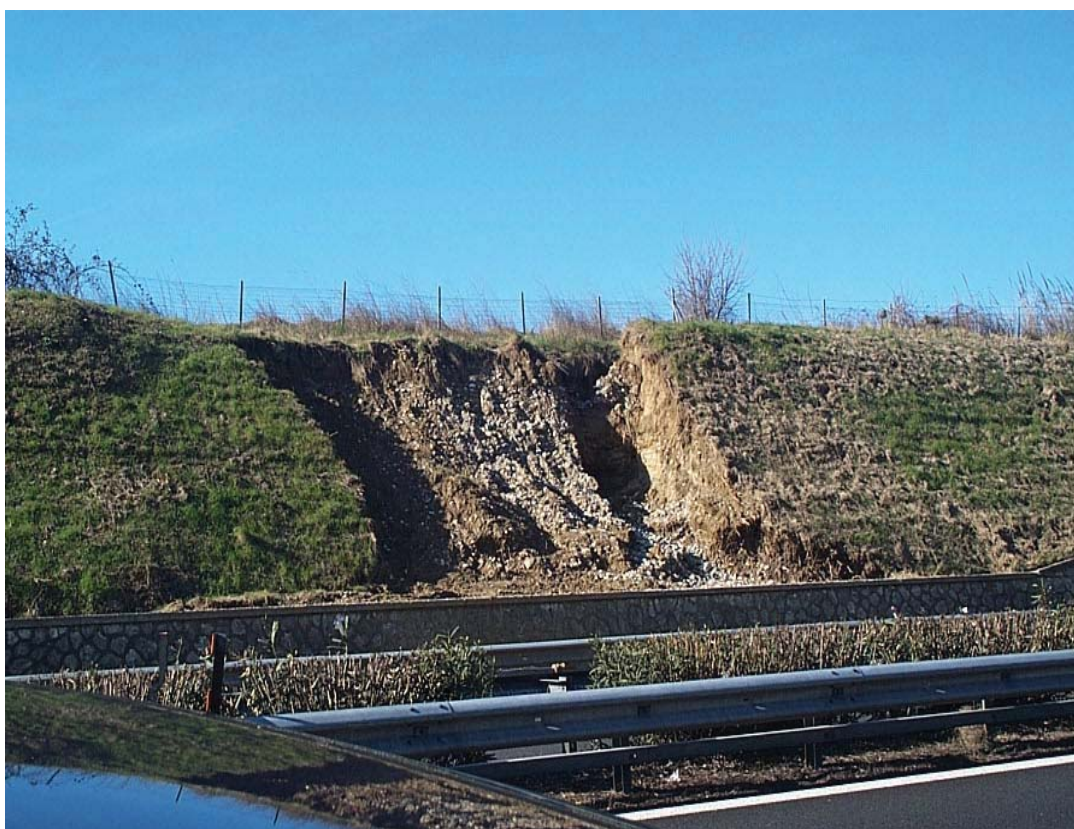
Foto 15: es. di erosione sulla trincea
