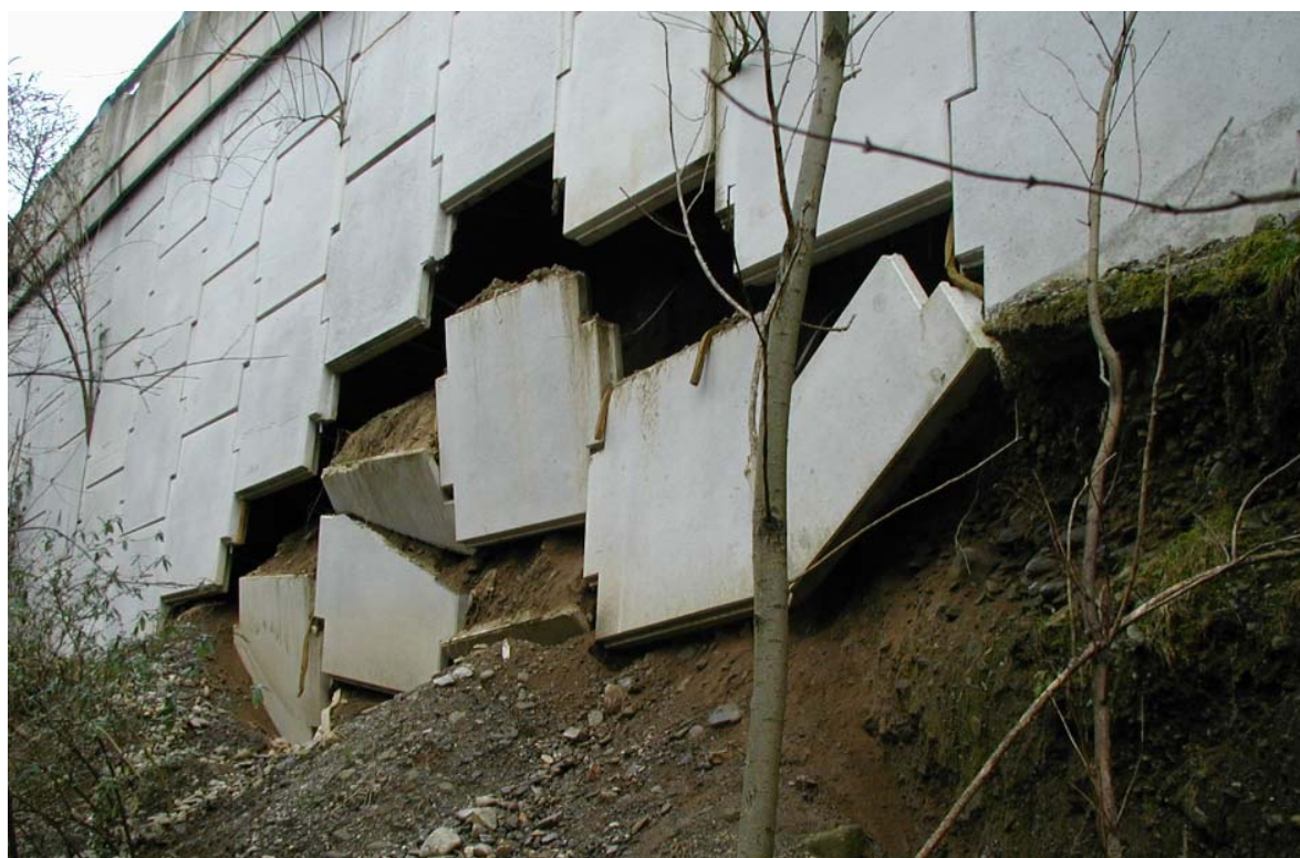
Foto 23: muro su cui sono visibili dislocazioni e rotazioni in corrispondenza dei giunti
