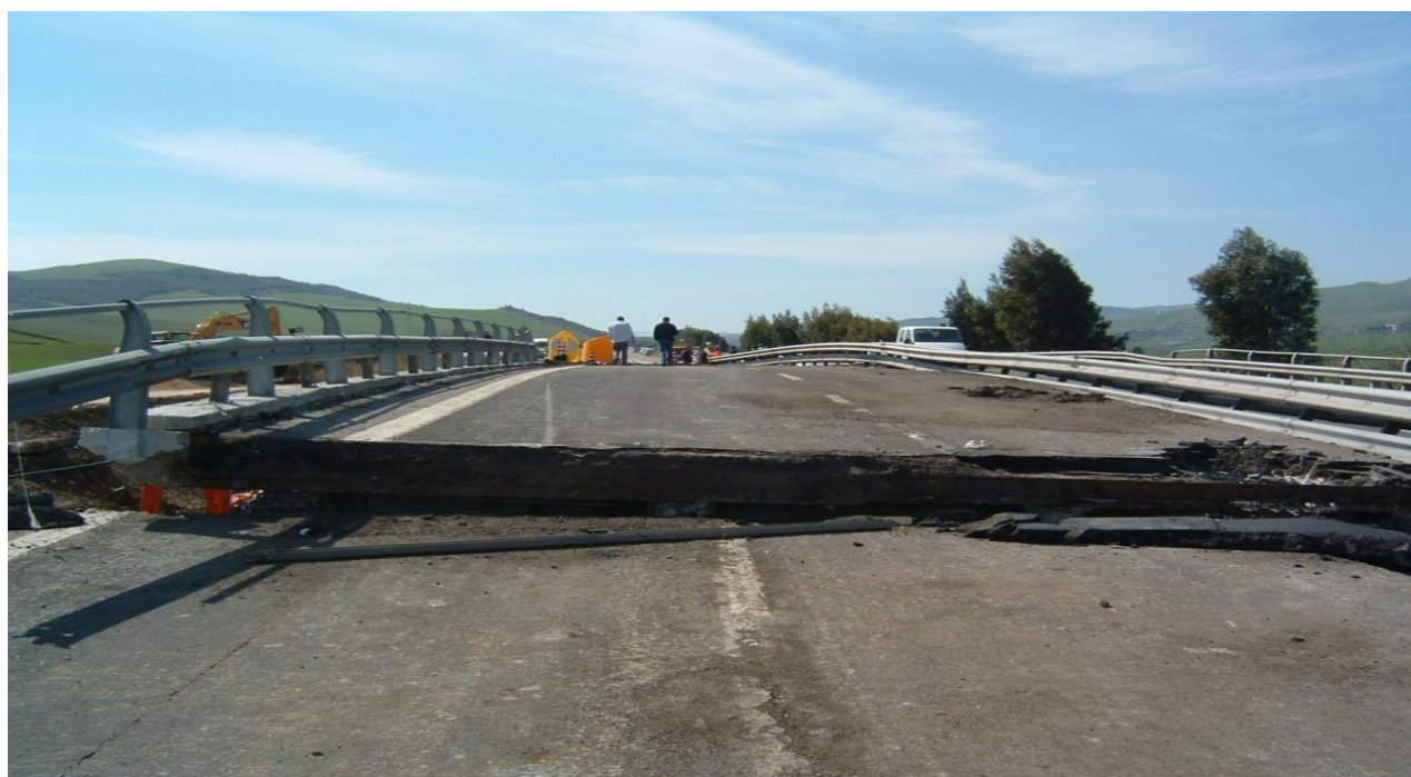
Foto 33-34: es. di evidenze di frana su un versante (lacerazioni, scarpate, contropendenze) a monte della sede autostradale e relativi effetti prodotti dal dissesto sul viadotto autostradale
