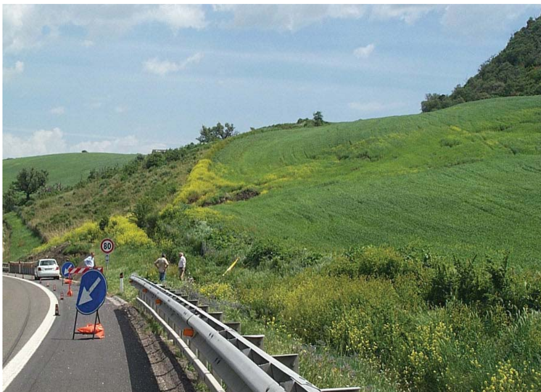
Foto 18: es. di frana rotazionale profonda che coinvolge la carreggiata e il pendio a monte; nonostante il versante a monte della carr. E sia coltivato, si notano delle fratture e contropendenze.
