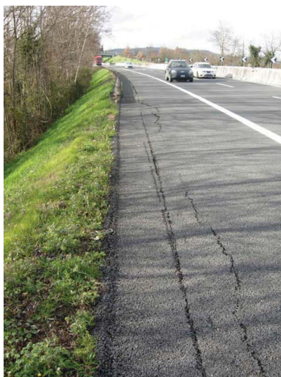
Foto 1 e 2: es. di instabilità banchine
