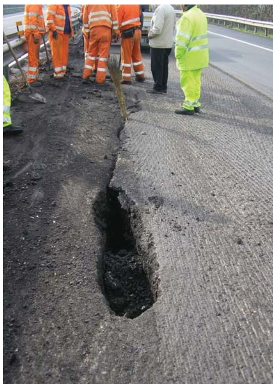
Foto 9 - 10: es. di instabilità del corpo del rilevato con coinvolgimento del piano di posa; in questo caso le deformazioni sulla pavimentazione della carr. Ovest (lato di valle), si spingono fino alla carreggiata di monte (carr.E), come evidenzia la rottura del rilevato.
